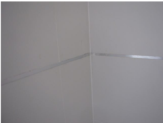
6.2. רובע בין אריחי קרמיקה בגוונים שונים ולפעמים שקועים. נדרש: לעכור על רובע קרמיקה בקירות.
