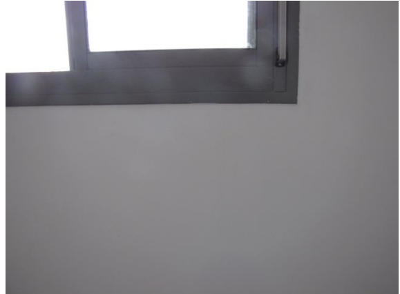
2.1. חדר שינה שמאל, סימני רטיבות בתחתית החלון. נדרש : איתור ואיטום מקור הרטיבות, תיקון צבע.
