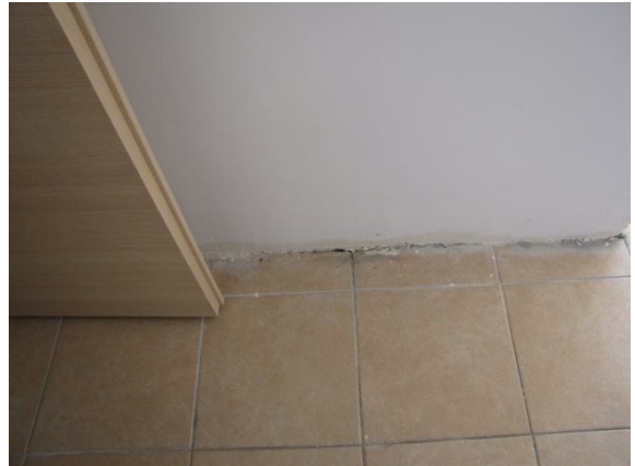
9.3. ריצוף פרקט, חורים בין קיר לריצוף, מרצפה שבורה בריצוף פרקט. נדרש : לסתום חורים עם מלט, להחליף בלטות שבורות.
