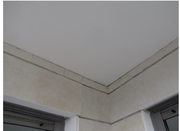
11.3. כחלה במפגש חיפוי אבן עם תקרה, וכחלה כללית לא אסטטית. נדרש : שיפור הכחלה במרפסת.
