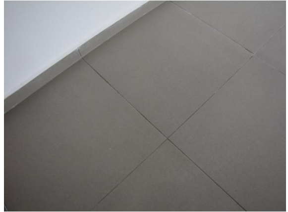
9.1. מספר בלטות שבורות בסלון, רובע בגוונים שונים ולפעמים רובע שקועה. נדרש : החלפת בלטות שבורות, לעבור על הרובע
